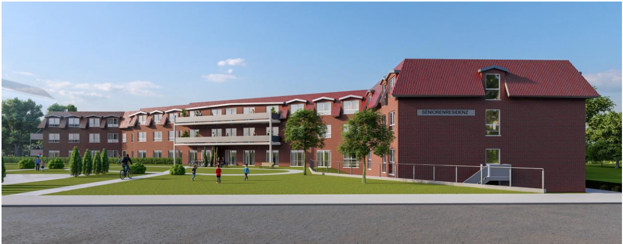
Ansicht von Westen vom Einemhofer Weg
